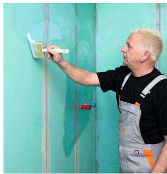
1. Грунтование поверхности: впитывающие основания на гипсовой основе и из гипсокартона следует грунтовать PCI® Gisogrund.
