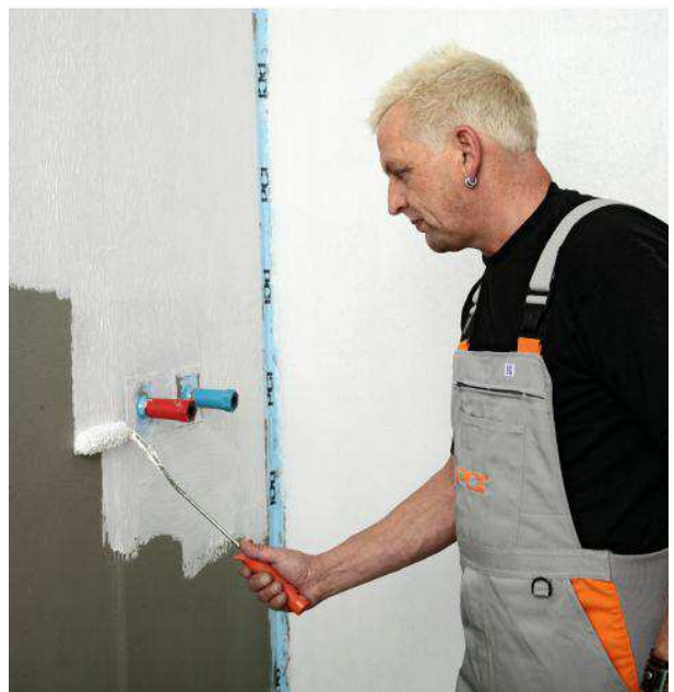
Нанесение неразбавленного PCI® Lastogum на основание с помощью валика.
