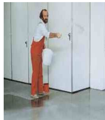
Обсыпание свежего слоя грунтовки кварцевым песком.
