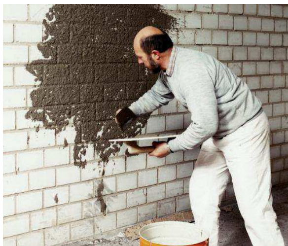
С PCI Emulsion нанесенная набрызгом штукатурка имеет улучшенное сцепление с основанием
