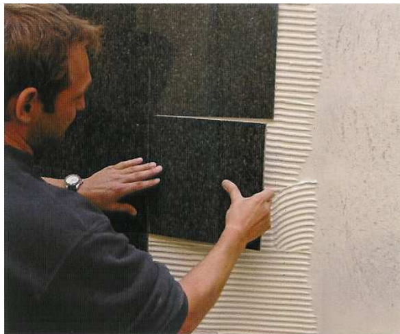
Облицовка стен натуральным камнем с помощью клея PCI® Carralight.
